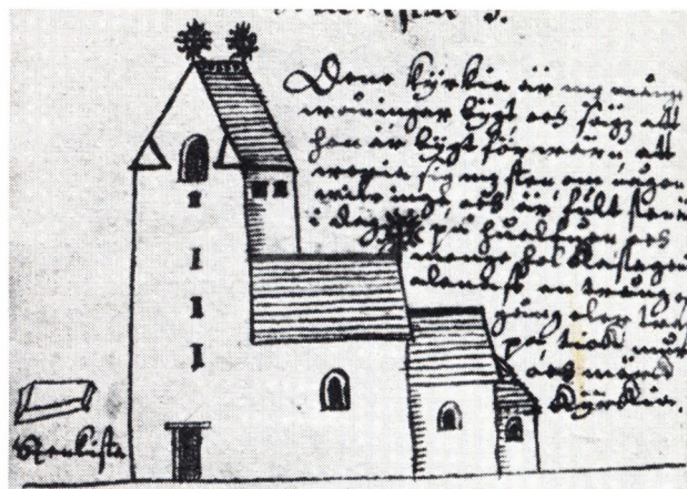
Fig 3. Smedby kyrka år 1634. Teckning av J H Rhezelius. KB. – Tornet, som av allt att döma var byggt över långhusets västra del, störtade ned 1774. Det var en följd av att man hade rivit bort valven i tornets nedre del för att få plats med en läktare. Resten av kyrkan ersattes 1852 med en helt ny byggnad.
