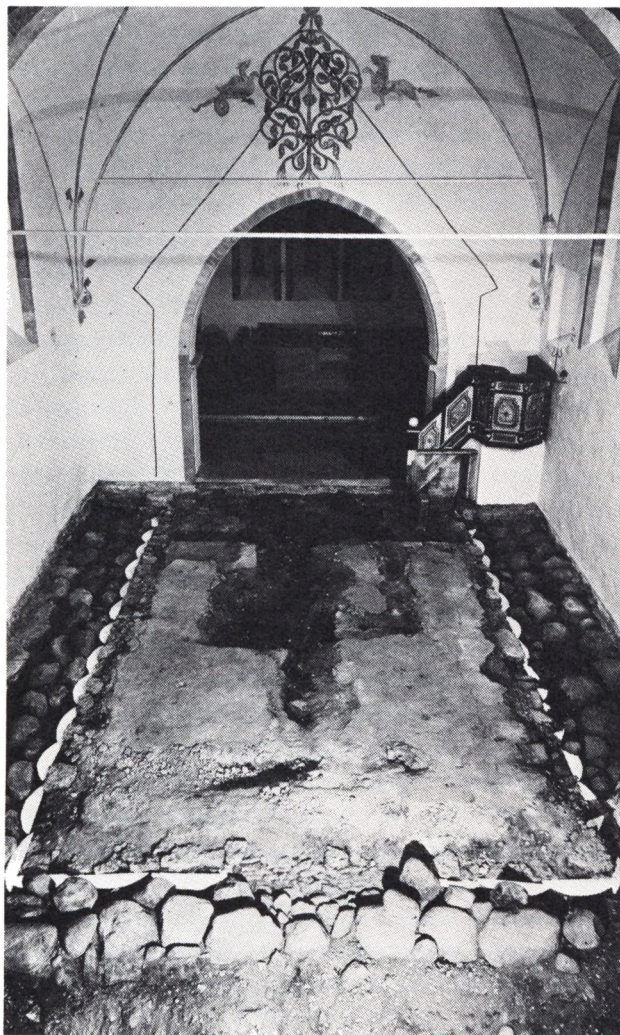
Fig 3. Silte kyrka under utgrävning, observera stavkyrkans takfall markerat på långhusets östra vägg. Foto W Falck.
