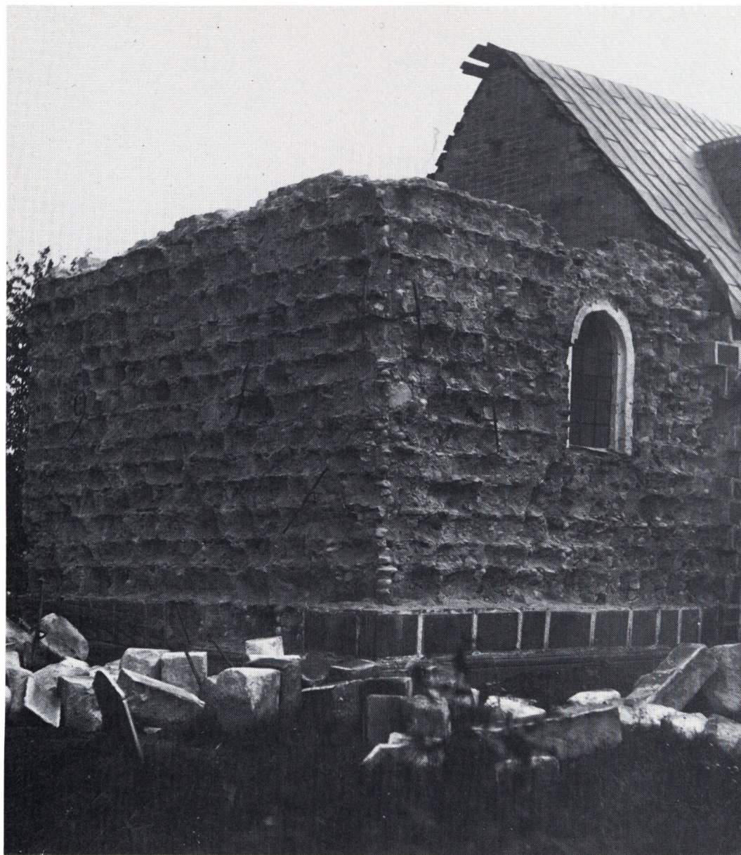
Fig. 12. Kassemurens opbygning. Den »afklædte« mur viser, hvordan hvert skifte granitkvadre har været opklodset med små kampesten (Hallund kirke, Hjørring amt).
