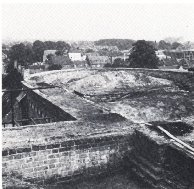
Fig. 4. Roskilde domkirkes korparti efter oprensningen. Det var en stor overraskelse, at murkronens teglsten og hvælkuplernes pudslag var næsten upåvirket af den voldsomme ild.
