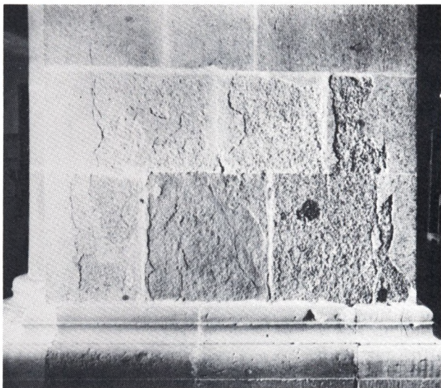
Fig. 9. Ribe domkirke. Alle arkadepiller af granitkvadre er på de nedre skifter skadet af jordfugtighedens indhold af humussyre.
