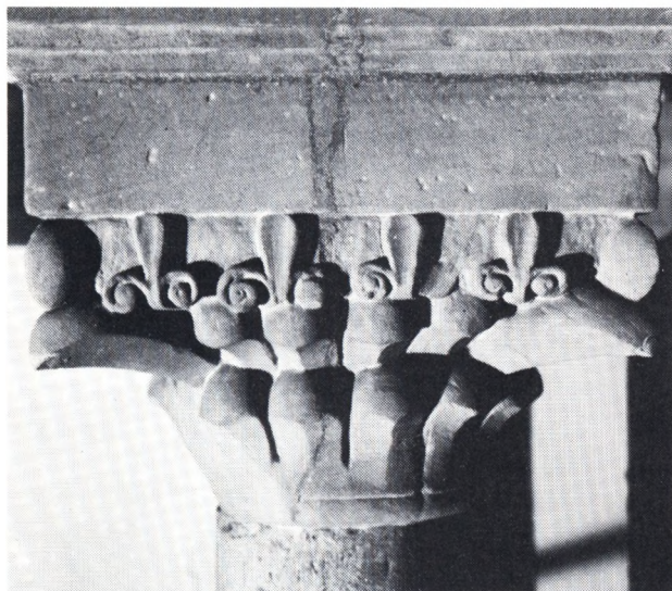
Fig. 8a-b. Ribe domkirke. Kapitæler fra de søndre triforier. Deres øst-vestgående revner skyldes uensartet tryk fra den spaltede høj Kirkemur (sml. fig. 5).
