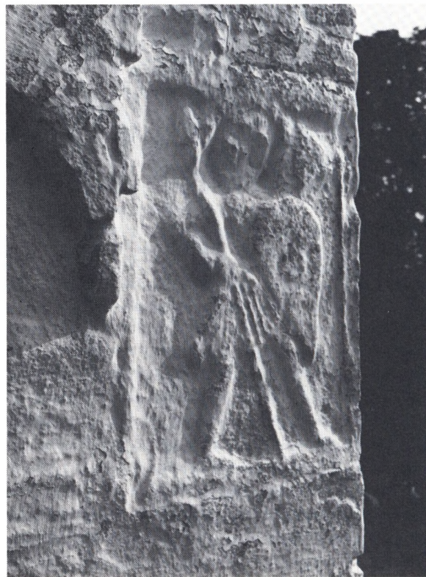
Fig. 9. Krigerkvaderen på Enslev kirke, som den fremtræder i dag med tidlig morgensol fra højre. Konturerne står udviskede på grund af gentagne overkalkninger. Den burde ved lejlighed renses, konserveres og derefter igen dækkes med et tyndt (!) kalklag. Foto: Poul Pedersen 11.7.1976.
