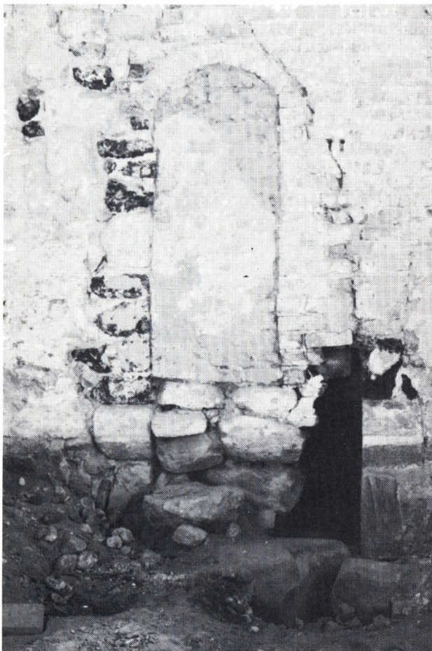
Fig. 12. Ramløse kirke. Tårnets sydvæg. Sekundær tilmuret tårntrappedør i den oprindelige sydportal, hvis vestre vange ses forneden til højre for døren.
