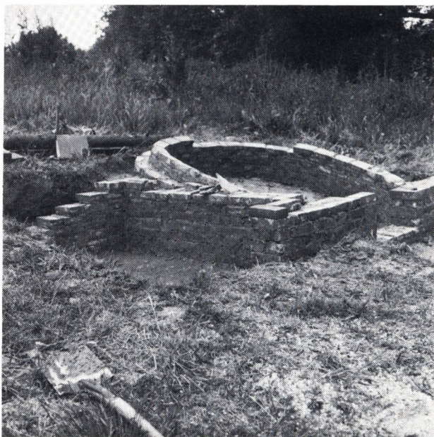
Fig. 3. Foto af opbygning af hvælvet af ovn III
