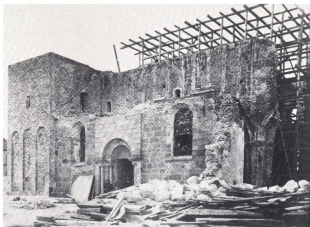
Fig. 12. Domkirken under nedbrydningen af vestdelen. Bemærk at sydsiden af tårnet er bygget i tegl næsten fra grunden. Ukendt fotograf 1868.
