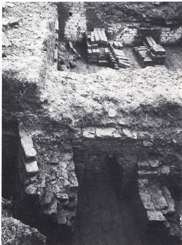
Fig. 24. Teglovn ved Lindeballe. I forgrunden ses frontmuren og den østlige indfyringsåbning mellem to stræbepiller. I ovns indre står en del af de opstablede sten fra sidste brænding tilbage. Fot. C. M. Smidt 1915.
