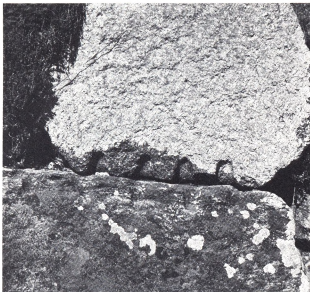
Fig. 5. Vestervig (Jylland). Granitkvader i kirkediget. Romanske kilehuller udført med stor præcision, og kløvningen af stenen er lykkedes perfekt; ved færdiggørelse af granitkvadre har man efter kløvningen bestræbt sig for at borthugge sporene af kilehullerne. V.N. fot.
