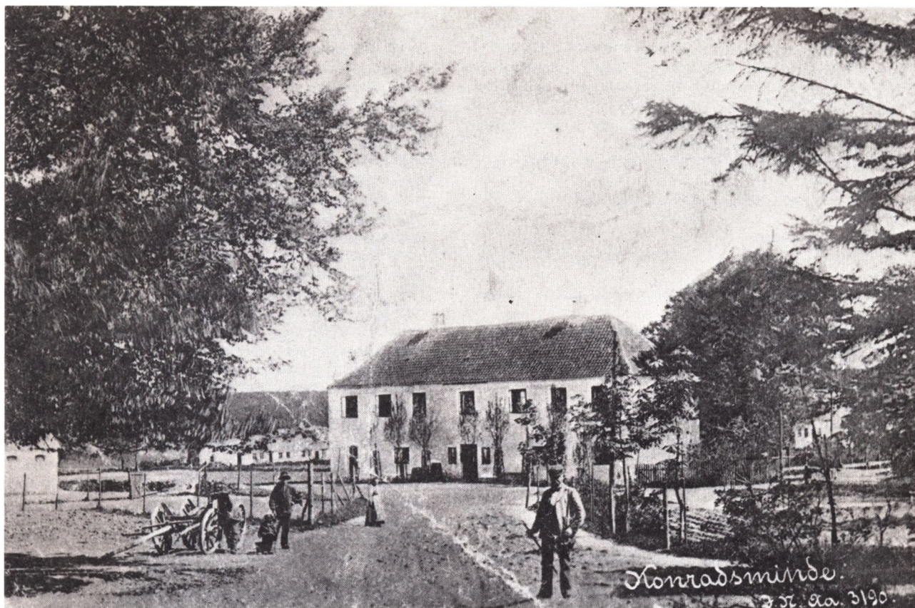
Fig. 7. »Konradsminde« i 80'erne efter et gammelt postkort. Hovedbygningen blev nedrevet i 1936 og det ombyggede porthus fra Kruses gouache (fig. 1) havde da fungeret som bolig for arbejdere, funktionærer, forpagtere og ejere gennem et lille århundrede.
