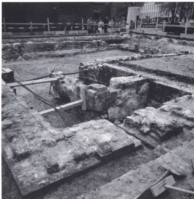
Fig. 7. Fundamentet af det tilføjede trappetårn. Den indre mur i kælderen var forstyrret af Thorvald Rasmussens gravninger og måtte understøttes. Tårnets murværk var det bedst bevarede i hele rådhuset.
