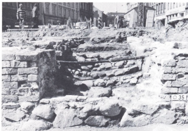
Fig. 5. Den oprindelige trappe på vestsidens nordre del. De ældste trappetrin er blottagt. Det forstyrrende el-kabel var anledningen til Thorvald Rasmussens undersøgelser.
