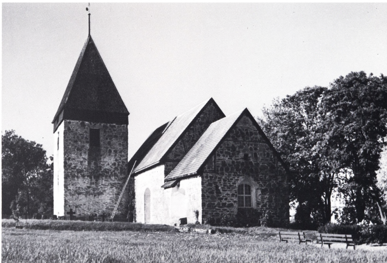
Fig. 7. Hammarlands kyrka från sydöst. Tornets ursprungliga ingång till andra våningen syns i fasaden till vänster. Foto Åbo landskapsmuseum, C J Gardberg.
