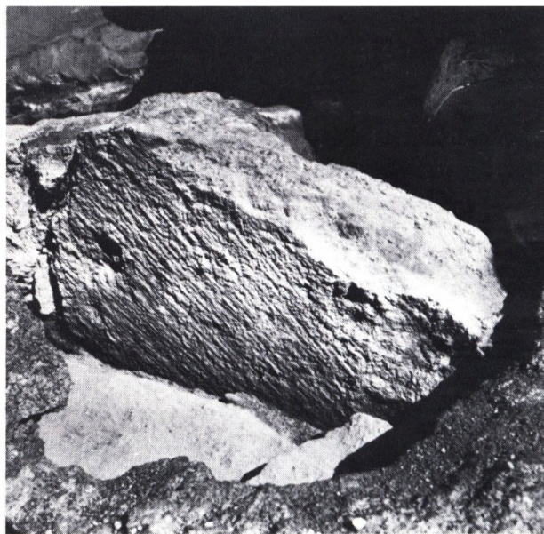
Fig. 10. »Allhelgonakyrkan«, hörnsten i långhusets SÖ hörn. Foto från S, E Swanström 1986.
