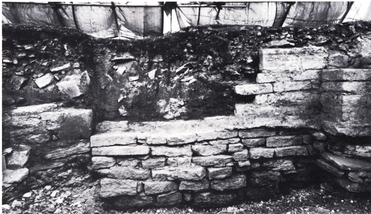
Fig. 8. Nordmuren i S:t Hans norra tvärskepp. T.v »Allhelgonakyrkans« sydostra korhorn. T.h tvärskeppets norra grundmur. Foto från S, E Swanström 1984.
