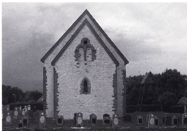
Fig. 7. Koret i Sørbo kyrkje, sett frå aust. I korgavlen står det ei dobbel nisje med eit lite, sirkelrunt vindauga over. Kyrkja har ingen dørøpning over korbogen, og har truleg hatt open takstol i koret (Bendixen 1909:151). Foto: A. T. Hommedal, 1982.
