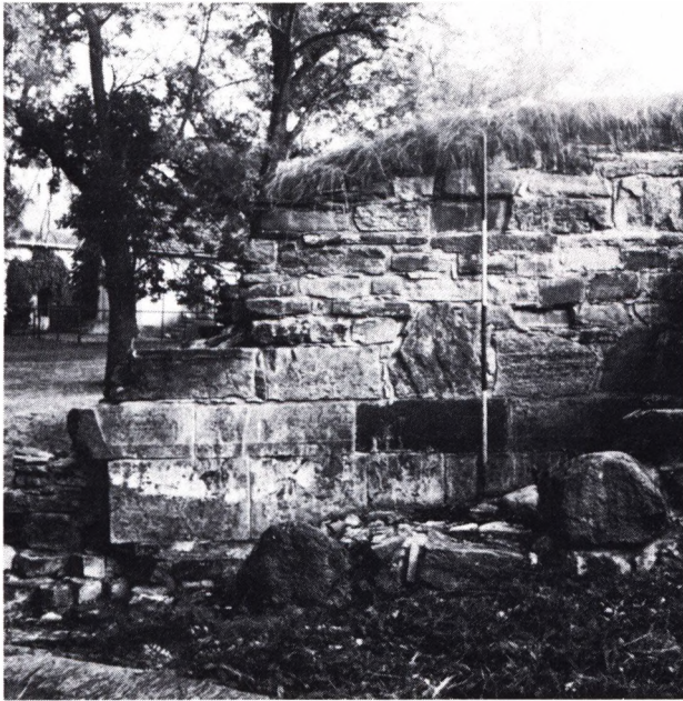
Fig. 7. Klosterkirkens sokkel ved korets ytre NØ-hjørne. En ser et kvaderskift med overliggende skrånfaset sokkel. Til venstre skimtes ansatsen til en lisene i det utrevne hjørnet. Over 1100-tallets sokkel følger det mer grove murverk fra 1200-tallet.
