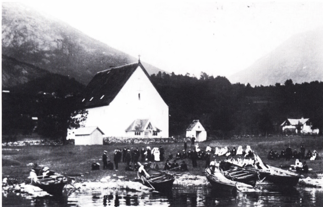
Fig. 2. Eldre foto av Kinsarvik Almanning med kirkebåter og bryllupsgjester. Legg merke til den store åpningen i kirkens vestgavl.
