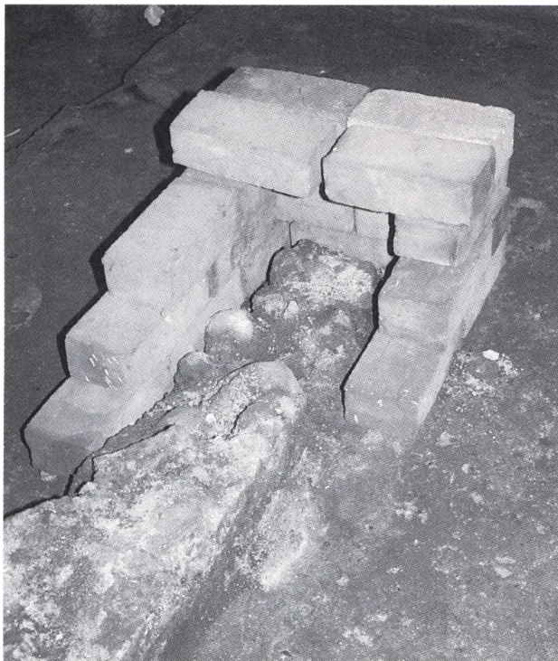
Fig. 9. Konstruktionen af de sekundære munkestensbænke illustreret med nye sten anbragt omkring den bevarede murkerne i nordsidens fritstående bæk. Foto BAH 1988.
