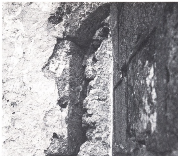
Fig. 6. Det vestlige vindue i korets nordside – delvis skjult af skibets kvadermur. Foto MAA 1985.
