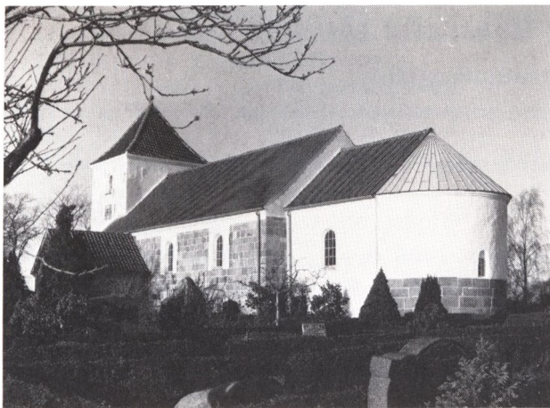
Fig. 1. Ravnkilde kirke efter den udvendige istandsættelse, set fra sydøst. Foto BAH 1989.
