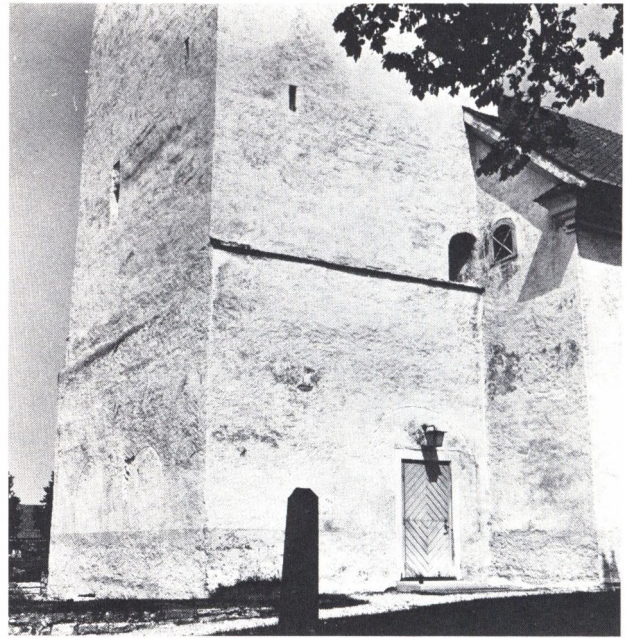
Fig. 6. Hulterstad. Det nuvarande tornet från sydväst. Fönstret upptill t h ovanför avsatsen tillhörde ursprungligen den äldsta kyrkans kleristorium. Efter Boström 1967.
