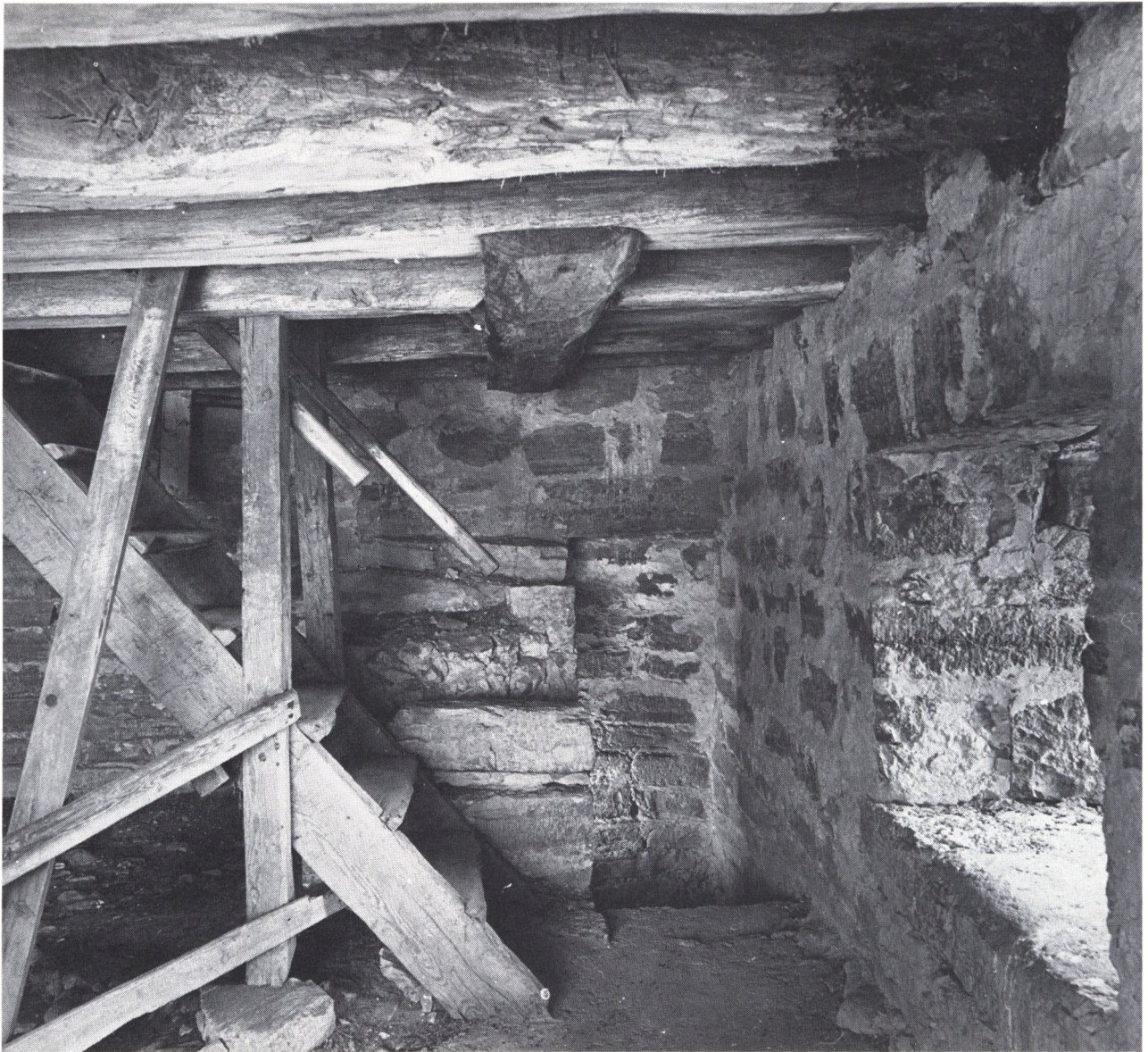
Fig. 10. Löt. Bjälklaget i översta tornvåningen. Efter Boström 1975. Av Bartholin daterat till 1390 ± 5.
