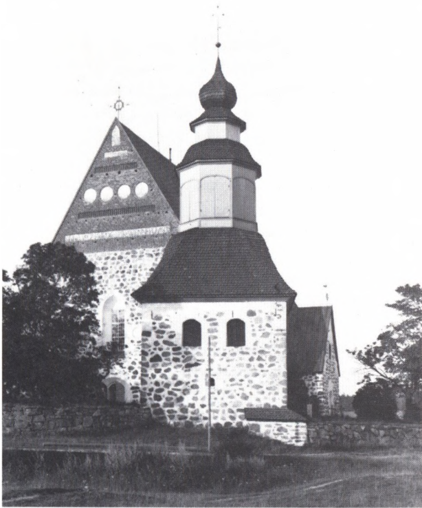
Fig. 4. Sagu kyrka och klockstapel. Övre delen av trä är uppförd av byggmästaren Anders Wahlberg 1770. Klockstapeln omnämns första gången år 1664, då den istandsätts; år 1698 täcktes den med bräder. MV, foto Carl Frankenhaeuser 1900.
