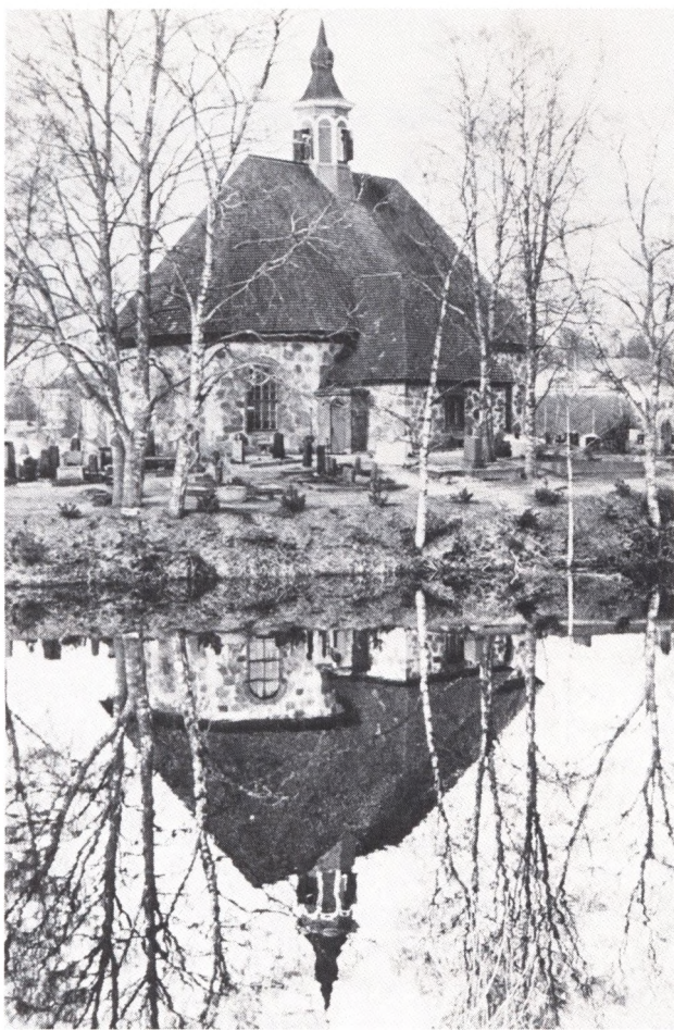
Fig. 4. Rengo kyrka under helgringningen i april 1984. Från NO. Foto Markus Hiekkänen.
