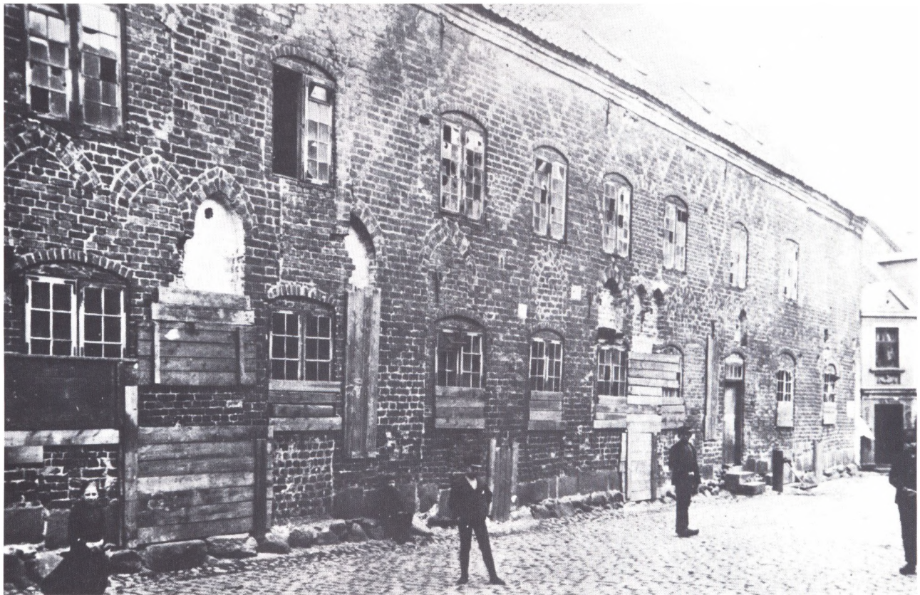
Fig. 40. Helligåndshuset i Randers før restaureringen 1894-97. Bygningens forfald er tydeligt, men murværket viser klare tegn på tidligere tiders herlighed. De østest tilmurede buer over vinduer og døre i stueetagen er klart spidsbuede. Foto fra 1894 på Randers lokalhistoriske Arkiv.
