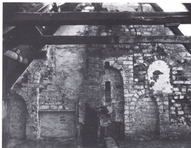
Fig. 28. Gavlen tilhørende nabohuset fotograferet fra »Budolfi«s øverste etage. Se også fig. 22-24. Neg.nr. 50.761.
