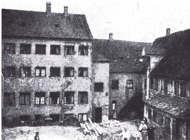
Fig. 24c. Gårdsiden af »Budolfi«-komplekset i nedbrydningsperioden. Jf. med fig. 37, hvor trappen i hjørnet genfindes. Den høje bygning til venstre er Mathiasgade 45a, som stadig eksisterer nogenlunde som på fotografiet. I bygningens murværk indgår dele af et middelalderligt stenhus. Gårdfacaden stammer dog fra en udvidelse fra 1843. Efter Th. Ditzel 1906.
