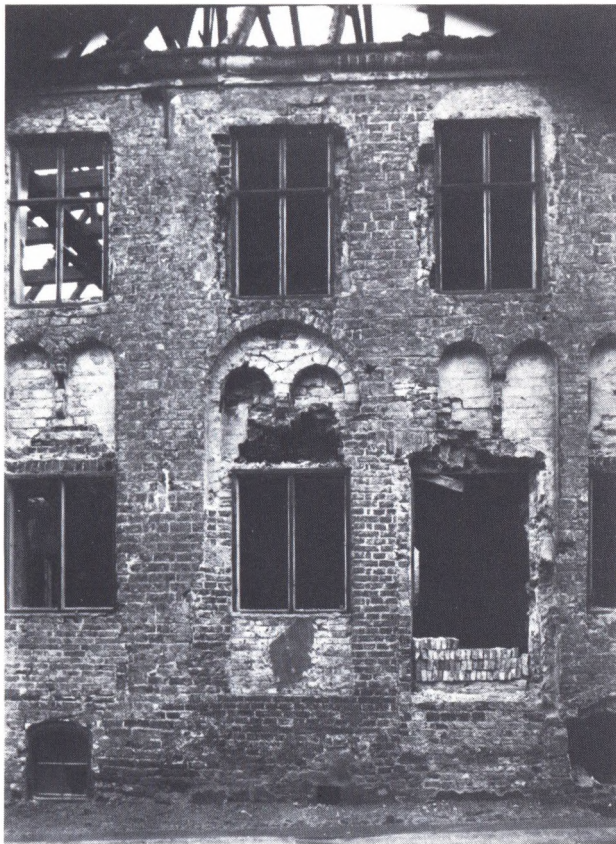
Fig. 32. Partiet omkring hovedindgangen med dobbeltbuerne under en større enkeltbue. Det udmurede parti under buen består af mindre sten. Her var den port placeret, som ses på Gulleus tegninger fig. 1, 3 og 4. Neg.nr. 50.749.
