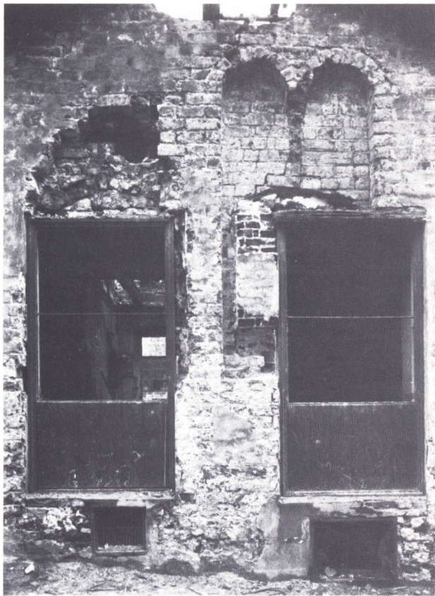
Fig. 36. Den nordligste del af Mikkelsgadefacaden, hvor rester af døren ses til venstre. Neg.nr. 50.755.
