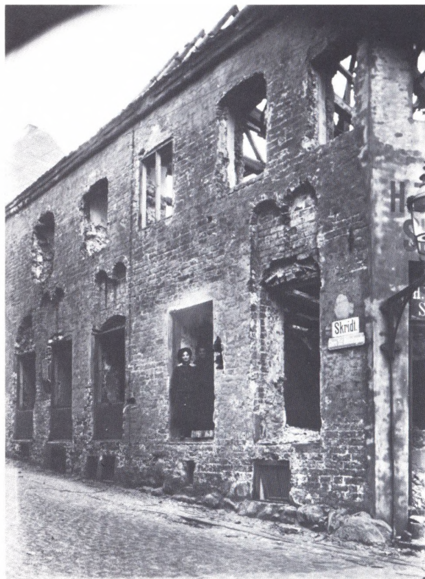
Fig. 35. Mikkelsgadefacaden med de mere uregelmæssigt placerede vinduer. Neg.nr. 50.753.
