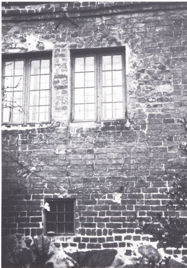
Fig. 21. Sct. Mogens Gade nr. 38. Udsnit af nordsidens murværk. Bemærk det lille tilmurede vindue til højre for de to nye. Foto: forf. 1979.
