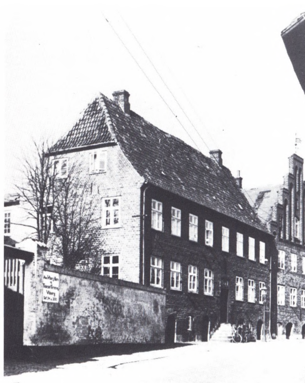
Fig. 9. Sct. Mogens Gade nr. 7. Til højre ses lidt af nabohuset nr. 9. Ældre foto i Lokalthistorisk Arkiv for Viborg kommune
