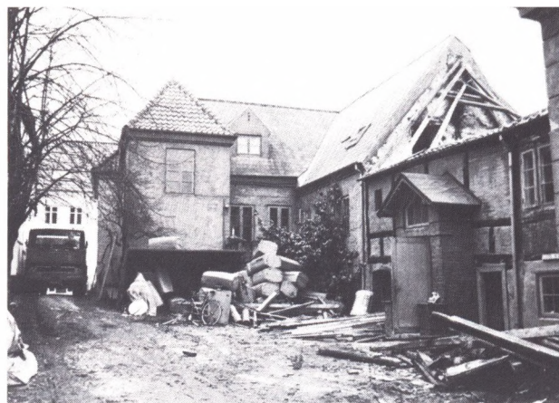
Fig. 23. Sct. Mogens Gade nr. 38. Gårdsiden under ombygningen. Foto: forf. 1982.
