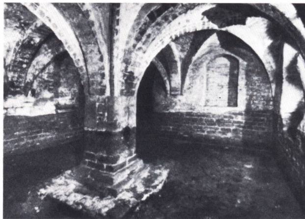
Fig. 22. Kælderen under Overgade 3 set fra nord mod syd. Kilde: F. Grandt-Nielsen, To middelalderlige stenhus i Odense. Fynske Minder 1970 s. 139.
