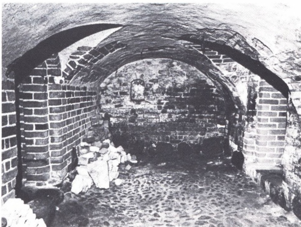
Fig. 31. Det ombyggede hvælv i kælderen.
