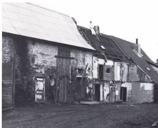
Fig. 7. Adelgade 15's bagside før restaurering, med tydelige spor efter lodrette revner, der måske skyldes at muren oprindeligt var bindingsværksbygget. Foto: Nat mus II afd.
