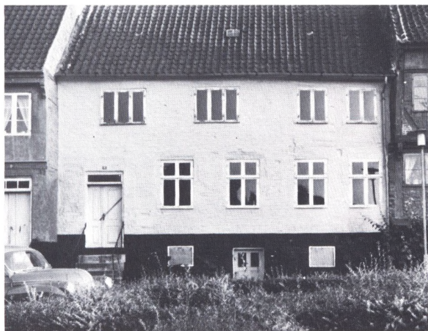
Fig. 4. Adelgade 15 før restaurering 1979.
