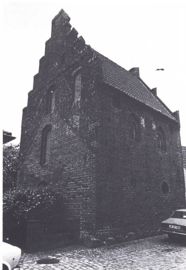
Fig. 32b. Østgavlen med markering af de tre synlige tagspor. Det laveste svarer til husene, der blev nedrevet 1938.
