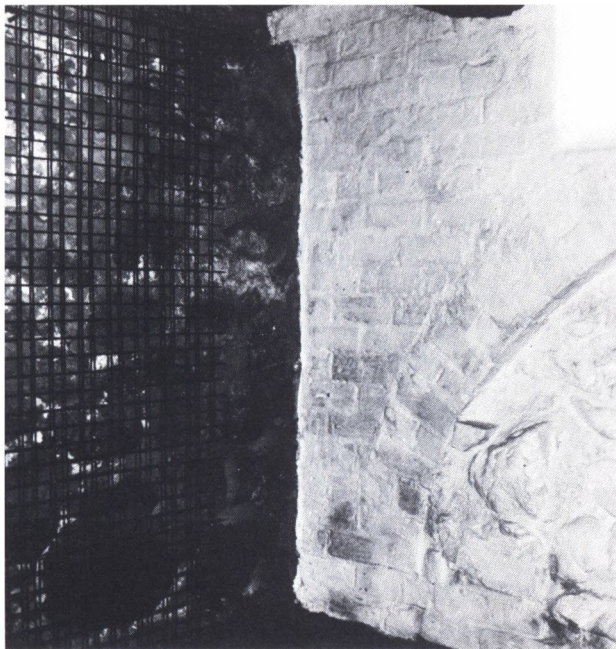
Fig. 10. Væggen i kælderen mellem Adelgade 4 og 6.
