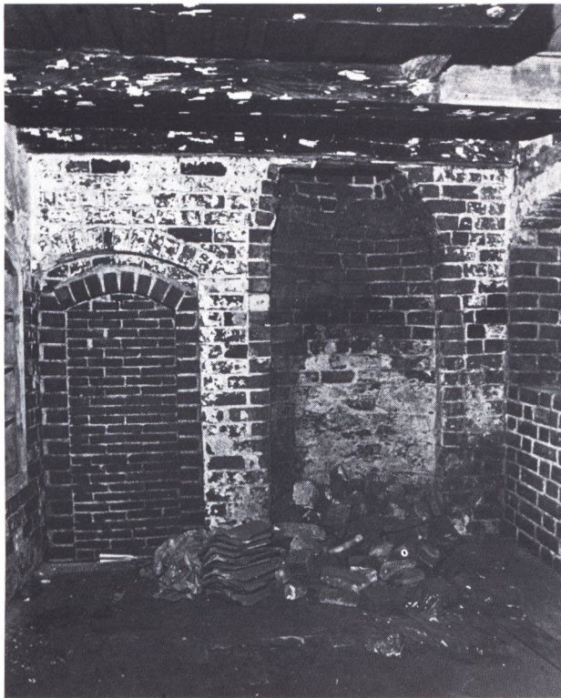
Fig. 27. Rester af kaminen i stueetagen.
