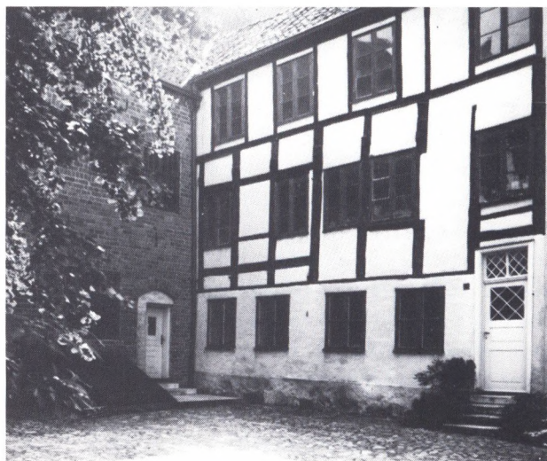
Fig. 19. Rosenvingeska huset i Malmö. Gårdssidan med den västra flygeln från nordöst. Foto S. J. 1983.
