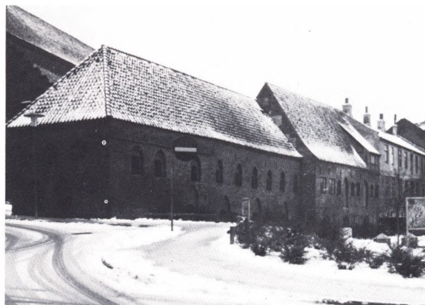
Fig. 5. Husraden söder om S:t Peders kyrka i Næstved sedd från väster. Från väster Henrik Gottschalks hus, »Trebodshuset« och Mogens Tuessens bodar med modern påbyggnad i öster. Foto S. J. 1980.
