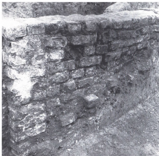
Fig. 8. Sydmuren i trappeskakten F.
