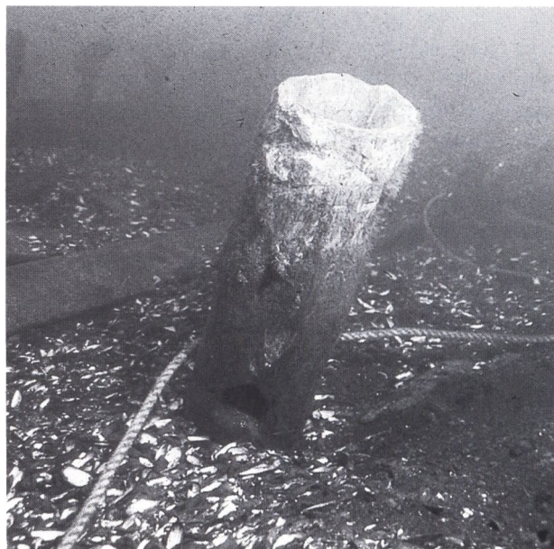
Fig. 6. Pumpen set agtenfra. Lige over skallerne ses hullet fra tuden, der har ledt pumpevandet ned i den hule pumperende. Foto: Sven Erik Jørgensen, 1987.
