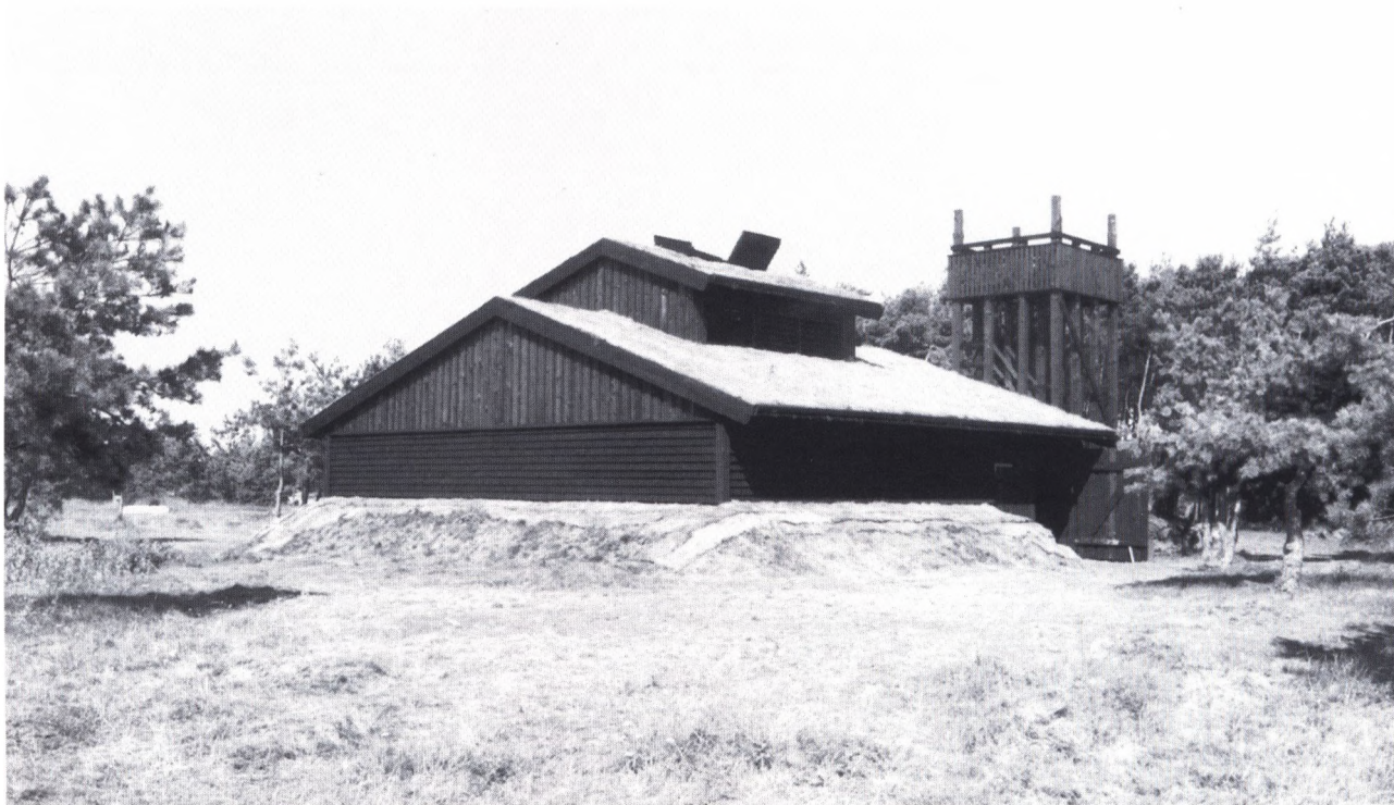
Fig. 45. Sydehytten med røgklapperne åbne. Bagved ses Rønnertårnet, hvorfra de flade fredede arealer kan beskues. Ca. 1,5 km mod SØ ligger den genskabte ruin 256. Foto: J.V. 19.8.1991.
