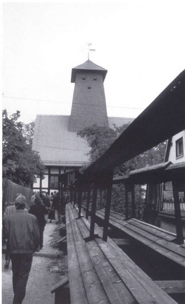
Fig. 88. Den 180 m lange »Doppelkunstgestänge« i Bad Kösen syd for Halle leder kraften fra et vandhjul i Saale-floden op til Borlach-tårnet for at drive en pumpe. 147 m nede fandt Johann Gottfried Borlach, »de saksiske saliners fader«, 1. juli 1730 kl. 3 om morgenen en saltlage på 4%, hvilket dengang var tilstrækkeligt til, at en produktion kunne indledes. Fra saltbrønden førtes lagen videre, nu med hjælp af en enstrengt »Kunstgestänge« op til det i 1780 opførte graderværk, som siden 1986 er under kostbar renovering. Foto: J.V. 1991.
