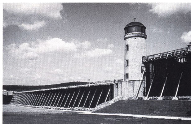
Fig. 48. I Bad Nauheim i Hessen har man indtil 1959 udnyttet en saltlage på blot 2-3 %. For at øge saltkoncentrationen byggede man allerede tidligt i 1700-årene graderværker med tjørn. I dag står i byen stadig 5 graderhuse med en samlet længde på 850 m. Produktionen udnyttes nu til kurformål. For at transportere vandet op til værkernes top blev der her, som andre steder, bygget vindmøller. Foto: J.V. 1991.
