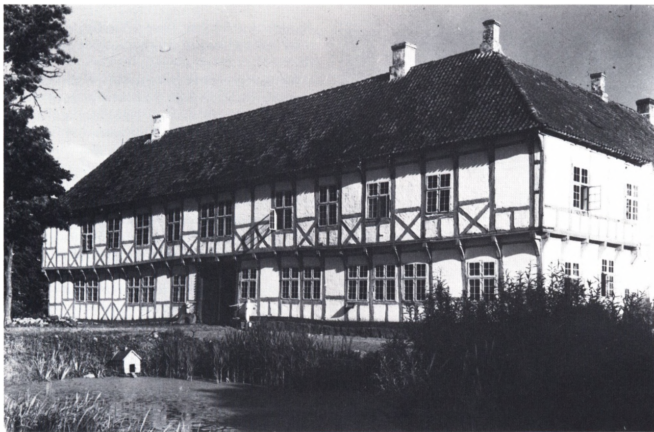
Fig. 1. Lynderupgård er opført i 1500-tallet, men sådan har en stor del af middelalderens storgårde set ud. Bindingsværksfløjene omslutter »det grønne tun«, man kender fra folkeviserne, og bygget ind i dem er et lille stenhus, »stenstuen«. Det var et brandsikkert rum til ejerens dokumenter og andre værdier, og voldgraven viste, at her boede folk af stand. Foto: Nationalmuseet.
