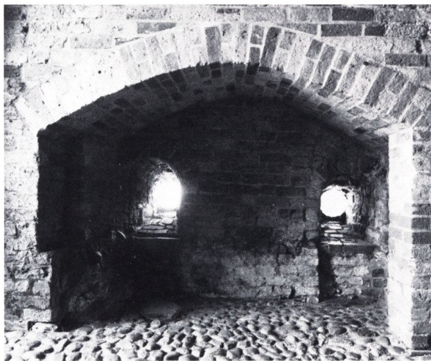
Fig. 31. De små rum på Hald, hvor kanonerne har stået, kan sammenlignes med forholdene på den næsten samtidige bispeborg Spøttrup, hvor bevaringssituationen er langt bedre. Her ses to skydeskår nederst i det fremskudte porttårn, hvorfra forsvarerne har kunnet bestryge fronten. Foto: J. V. 1991.
