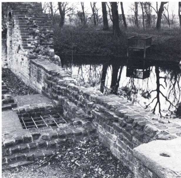
Fig. 28. Den søndre halvdel af Trøjborgs vestmur set indefra. I nederste højre hjørne »udslagsvasken«, til venstre en brønd, som har kunnet benyttes fra kælderen under sydfløjen, men vist nok også har været ført op til etagen ovenover.
