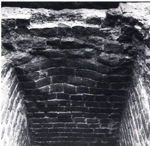
Fig. 27. Den øverste del af brøndskakten under portrummet, med slidspor efter spande.
