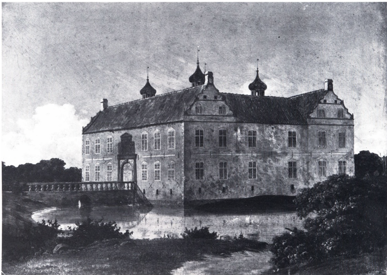
Fig. 12. Slottet set fra volden i nordvest. Den mørke bunke, som delvis skjuler vestsidens kvadersokkel, må være affald, især fra køkkenerne, som lå i denne fløj. Den murede bro erstattede omkring 1800 den tømrede vindebro, som ses på fig. 10. Oliemaleri, 35,5 x 47,5 cm, signatur ulæselig, ca. 1843. Privateje.
