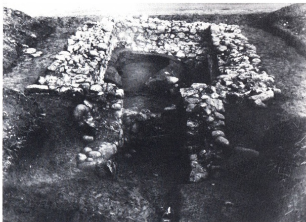
Fig. 11. Dresvold-bygningen set fra syd. I forgrunden spærremuren, og bagved ovenns yngste og bedst bevarede fase. Bygningens mure er aldrig fjernede, men står endnu bevaret under terræn. Foto: Hans Neumann 1949.
