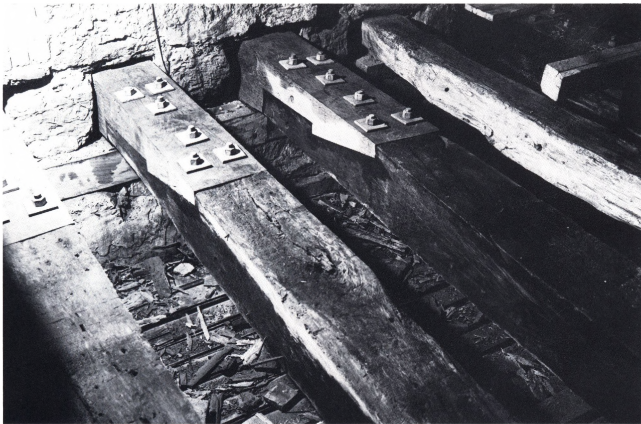
Fig. 6. Hopskarvningen av gammalt och nytt virke 1949-50. Bilden visar en del av bjälklaget över köket. I övre högra hörnet ses den sekundära furubjälken, som inte behövde skarvas. När bilden togs hade nya remstycken fällts in under bjälkarna. Foto: Helsingborg museum.
