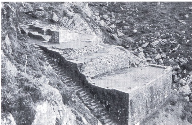
Fig. 5. Den store terrassen med ruinarne av Sunnivakyrkja, sett frå nord-vest. Terrassen ligg i dag restaurert i tre avsatsar. Cato Enger, som stod for gjenoppbygginga i 1930-åra, tenkte seg at heile terrassen i mellomalderen låg som ei stor flate i høgal med det øvste nivået nærast kyrkja. Meir sannsynleg er det vel kanskje at terrassen også då har lege i fleire nivå. Terrassane må ha vore nytta under liturgiske prosesjonar og som samlingsstad for pilegrimane på dei store festdagane, særleg Seljumannamesse 8. juli. Lengst inne på terrassen har den vesle Sunnivakyrkja lege som eit eige «relikvieskrin», og som oppbevaringsstad for dei eigenlege helgenskrina. Foto: A. T. Hommedal.
