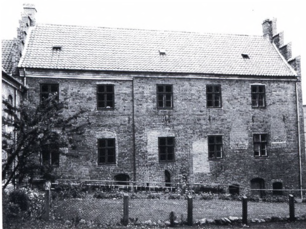
Fig. 12. I 1976 indledtes omfattende restaureringsarbejder af de bevarede dele af Gråbrødre Klosteret. Her ses sydsiden af den såkaldte udløberfløj med de mange spor af tilmurede døre og vinduer. Foto: J.V. 6.6.1976.
