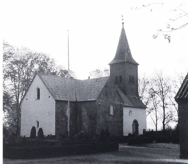
Fig. 12. Af Vejerslev Kloster er den noget ombyggede kirke eneste bevarede bygning. Foto: HG 1974.
