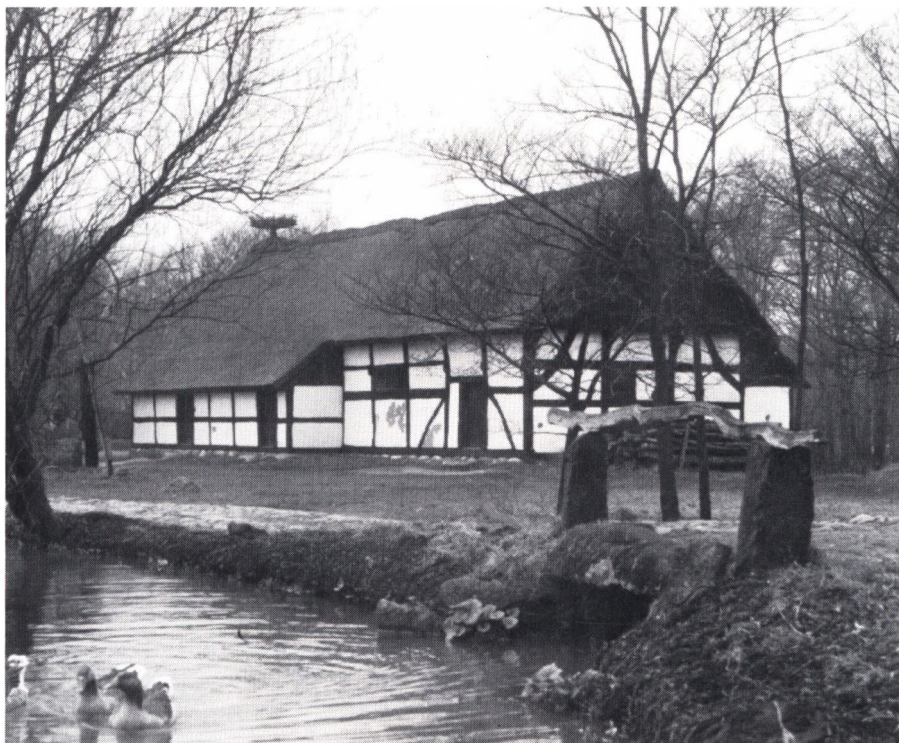
Fig. 12. Vinkelgården fra ca. 1530, som nu er opstillet på Hjerl Hede, er et godt eksempel på et hus med udskud. Udskudshuse optræder i Danmark fra midten af 1000-tallet. Foto: Jens Vellew 3.3.1974.
