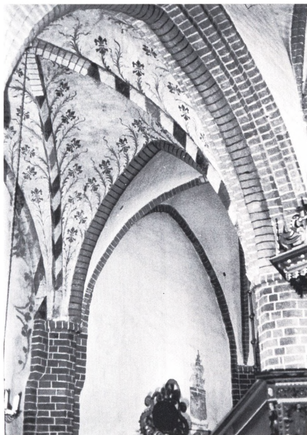
Fig. 10. Pargas (Eg Finl). Utsikt från mittskeppet mot norra sidoskeppet.
