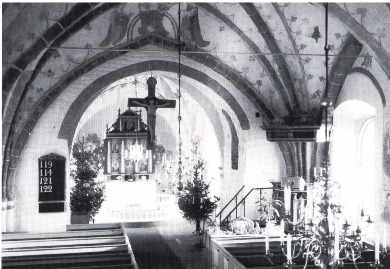
Fig. 2. Triumfbågmuren med trappöppningar. Foto: Göran Söderberg 1995.
