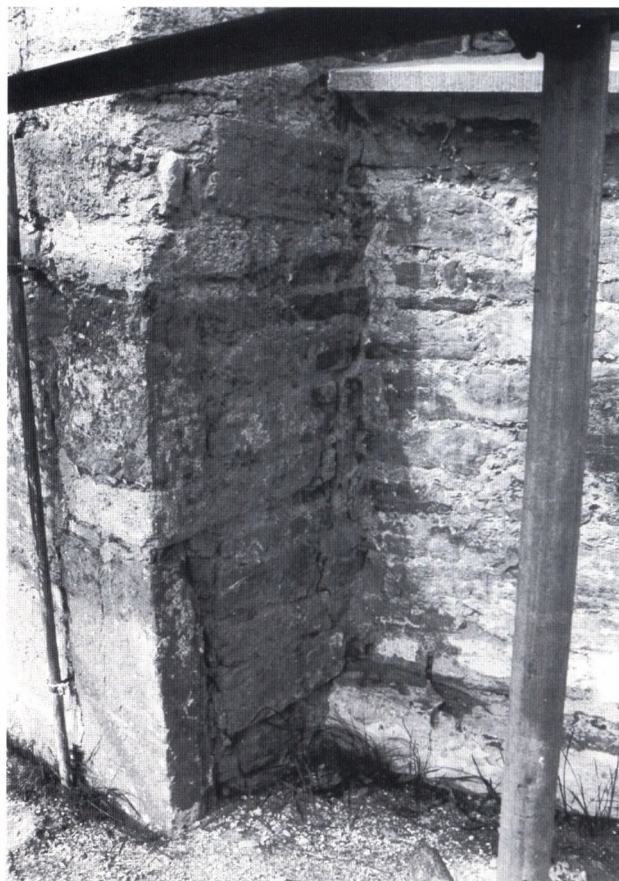
Fig. 22. Korets sydöstra hörn, murat av tunna kalktuffs- och kalkstensskivor, för att efterlikna en hörnkedja. Foto: KLM 1992.
