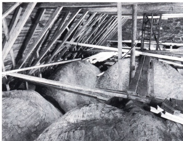
Fig. 3. S:t Bertils kyrka, Egentliga Finland. »Gotiskt« takstolssystem från 1500-1550. Foto P.O. Welin 1986. Museiverket.
