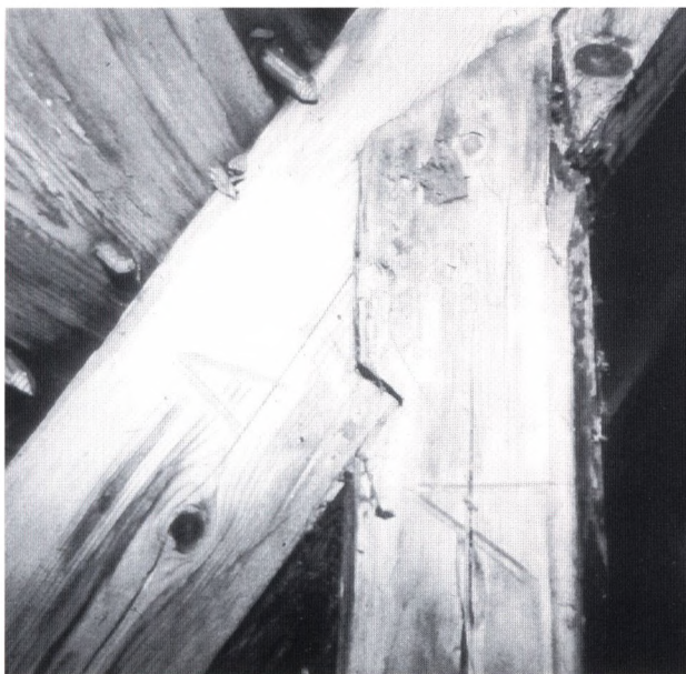
Fig. 9. Trondenes kirke, Troms. Detalj av takstol over skip. Foto: O. Storsletten 1990.
