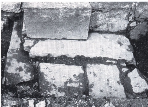
Fig. 10. Rest av murflukt ved det nordaustre hjørnet av skipet i Mariakyrkja. Muren til det nye skipet er lagt over den plane sokkelflata av store heller. Motivet sett mot sør. Foto ØE 1990.
