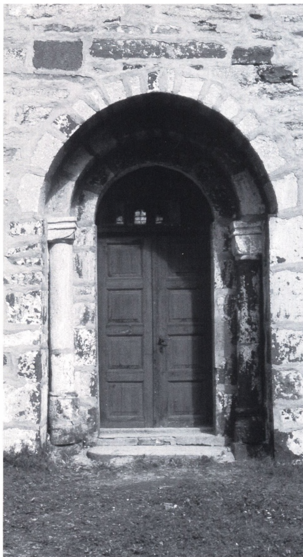
Fig. 13. Vestportalen i Mariakyrkja før restaureringa 1990-92. Merk at søylene har ulike kapitel og basar, og er hogd av to typer stein. Foto ØE 1990.
