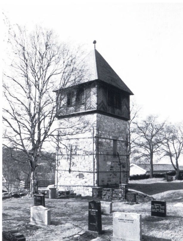
Fig. 5. Klokketårnet sett mot sørvest. Overetasjen av tre frå 1864. Midt i nordveggen dørøpning som har ført ut til parapet på ringmuren. Foto ØE 1990.
