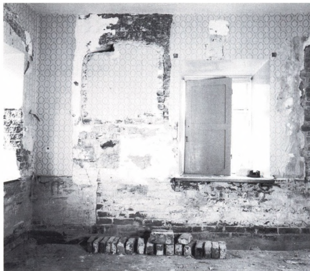
Fig. 4. Over det tilmurede vindue i sydvæggen i »Kongens Kammer« er frilagt nogle få rester af rummets kalkmalede udsmykning. I dag er vinduet genåbnet, mens det nyere vindue til højre er tilmuret. Foto: JV 19.8.1976.
