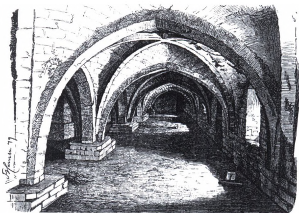
Fig. 11. Det vestlige skib i den sydlige del af vestfløjens kælder. Ude og Hjemme nr. 145 1880.
