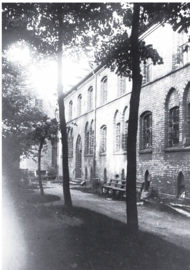
Fig. 12. Den nordlige del af klosters vestlige facade fotograferet i 1895, altså efter den radikale restaurering i 1880'erne, hvor ydervæggene blev skalmurede. Foto: Nationalmuseet.
