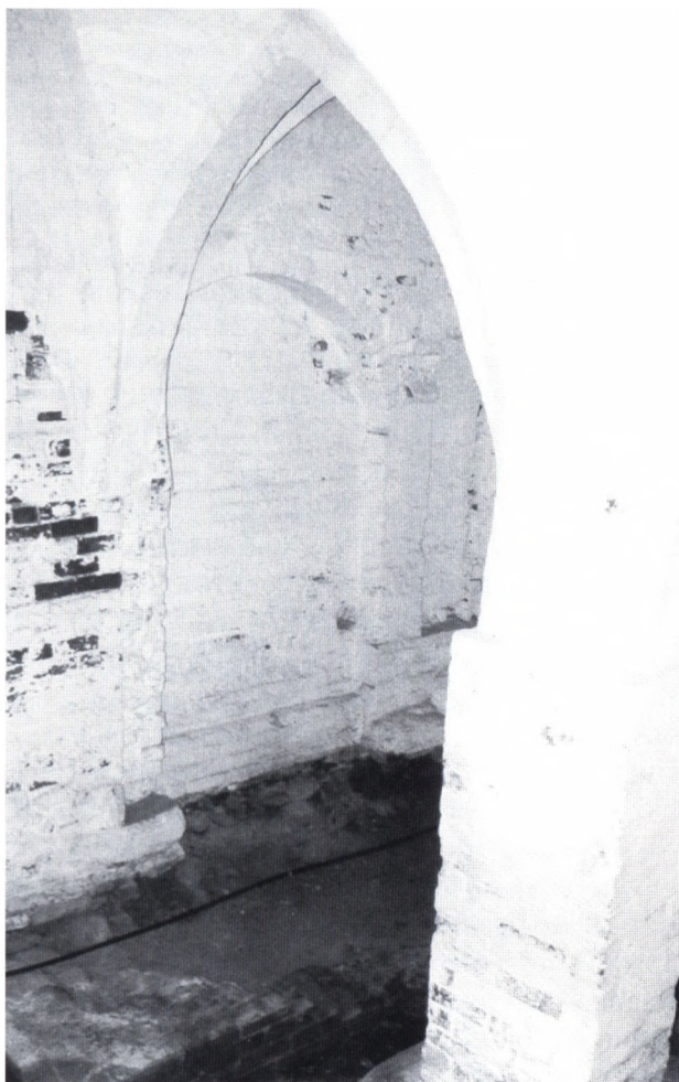
Fig. 3. Vestvæggen i Munkestuen set fra sydvest. I forgrunden ses hvælvpillen. Foto: Hans Skov 1995.
