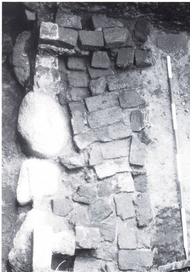
Fig. 9. Østfløjens vestfundament set fra nord. Til venstre ses spor af den grundmurede inderside på en kampestenssyld, mens rester af fundamentet er opbygget af teglstensbrokker. Foto: HKK 1991.
