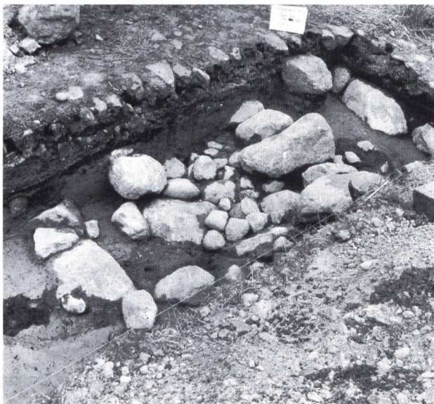
Fig. 12. Fundament JQ fra fase IV er anlagt midt imellem fase III-fundamenterne JAE th. i profilen og JAF tv., der har båret østfløjens korsgangsmur og vestmur. Felt J set fra nordøst. Foto: M1-54, 1972.
