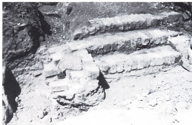
Fig. 10. Teglstenstrappen leder ned til kælderen under hus A, fase III. Snit V set fra øst. Foto: Fritz og Ry-Andersen 93, 1934.
